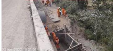
[Ver imagen completa](#)**Foto3:**Control de niveles para vaciado de caja disipadora
