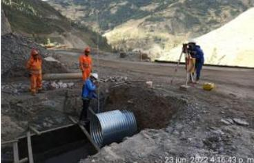
[Ver imagen completa](#)**Foto2:**Control de niveles para vaciado de caja de bajada
