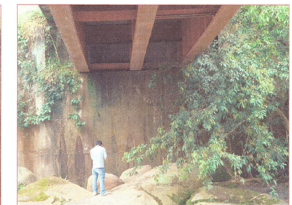
10 Vista de pantalla de estribo derecho
