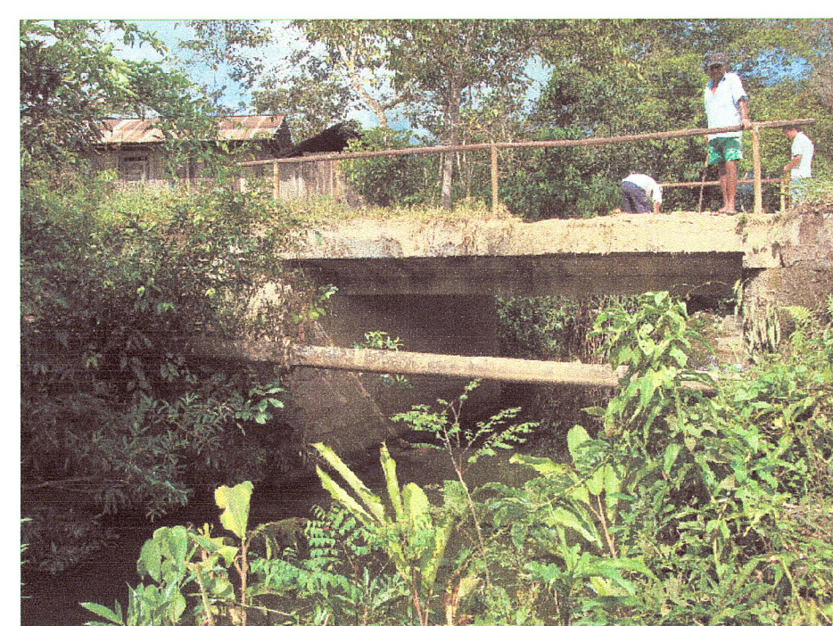
01 Vista desde aguas arriba del puente
