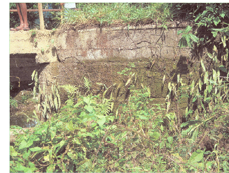
09 Vista de estribo del puente
