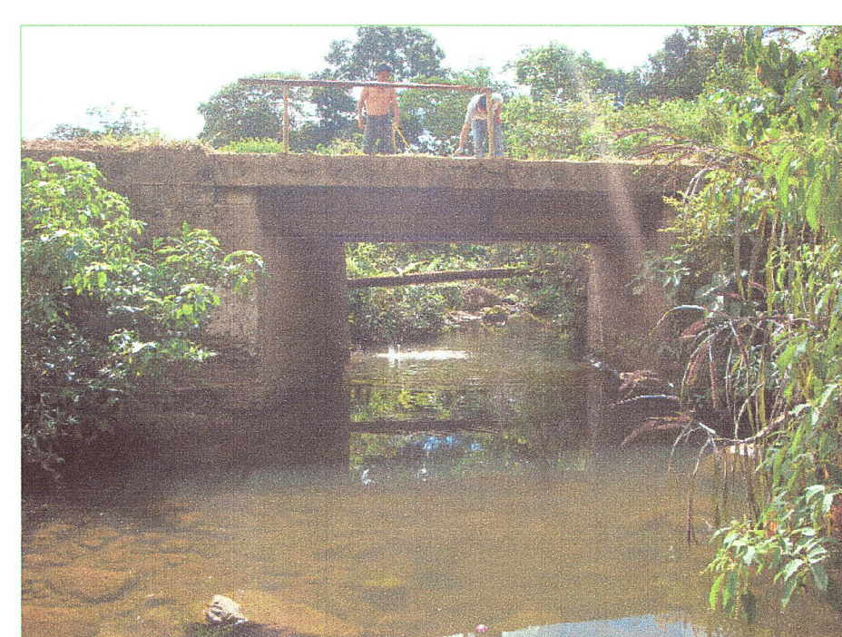
02 Vista lateral del puente
