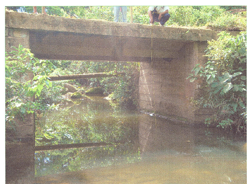
05 Vista lateral de vigas del puente
