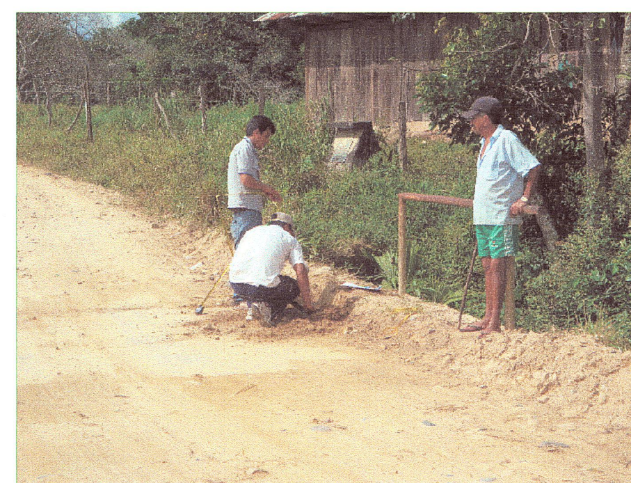
03 Vista de la superficie de rodadura
