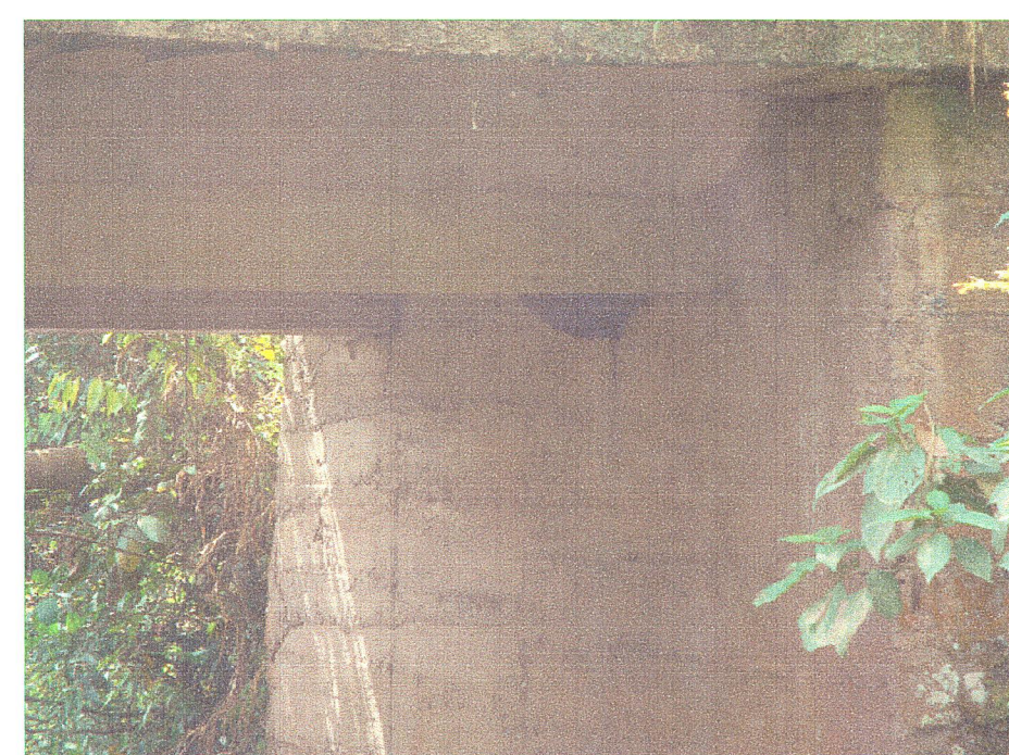
06 Vista de apoyos de viga en estribos
