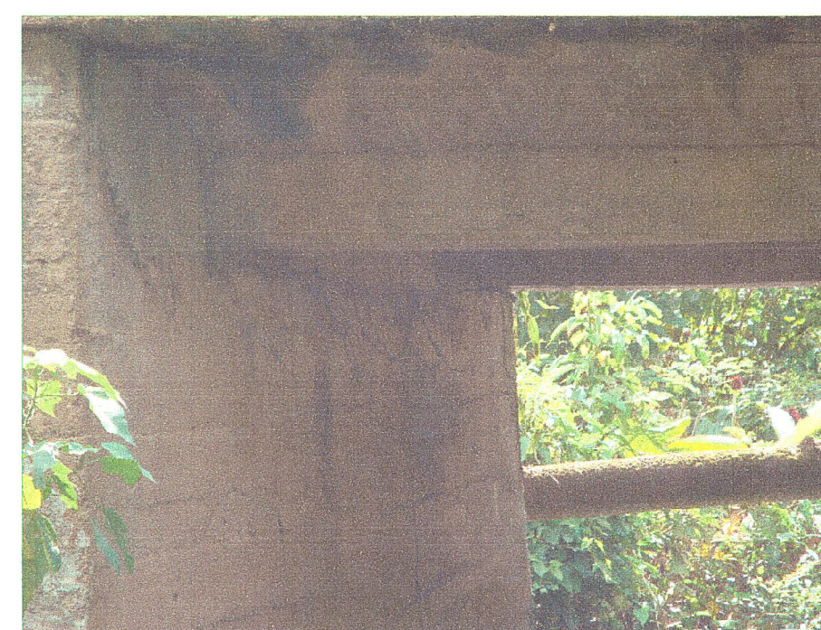
07 Vista de vigas inferiores del puente
