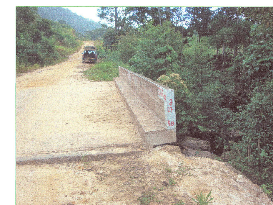
04 Vista de vereda y parapeto que estan como barandas del puente
