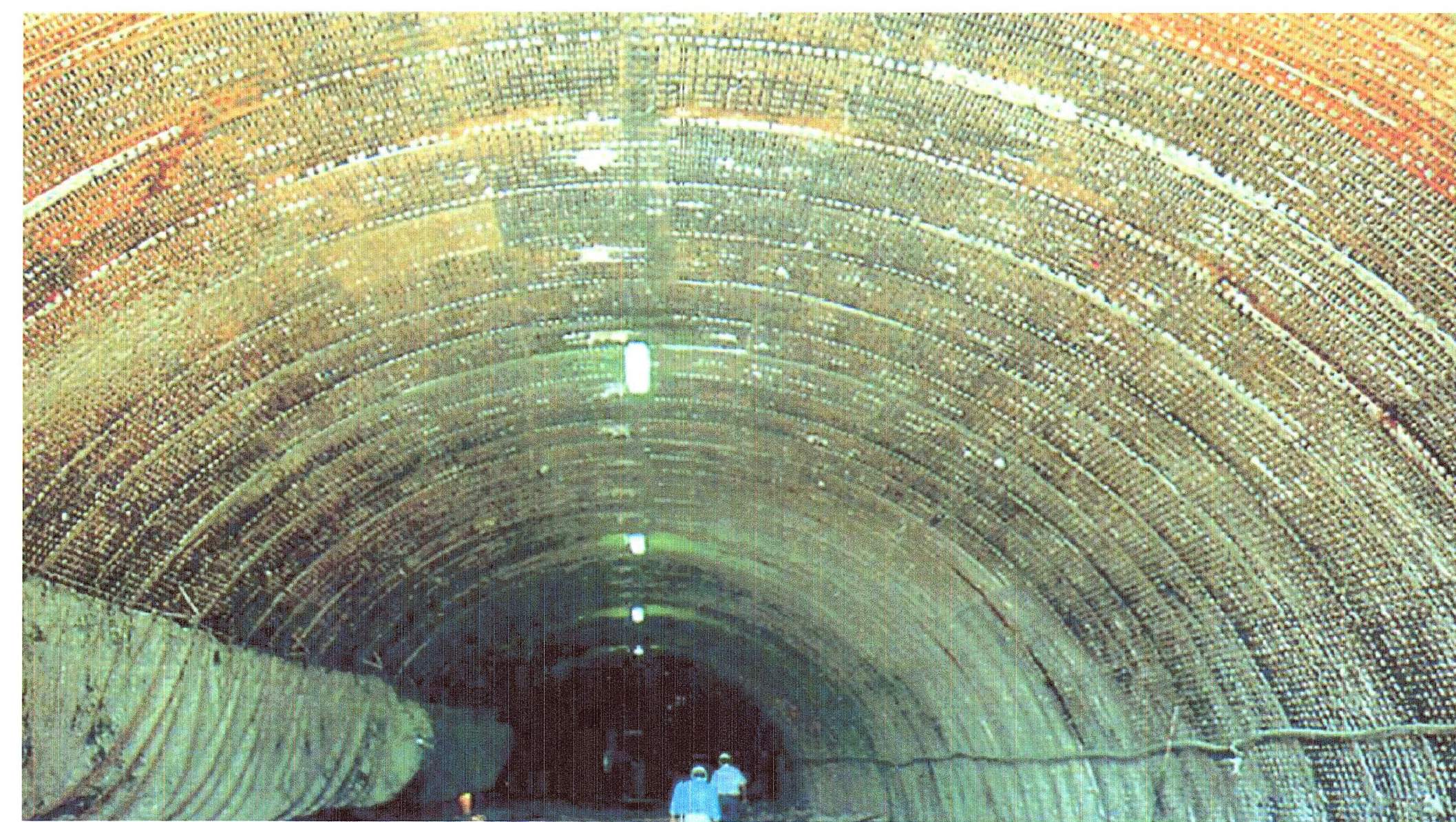
ACABADO TUNEL CON PLANCHA DE ACERO TIPO BERNOLD
