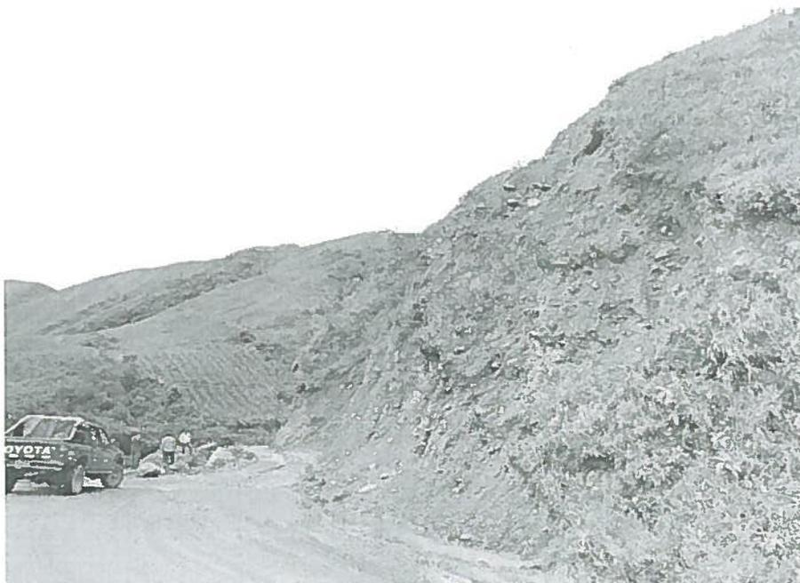
Foto N° 06: TRAMO 04 Progresiva 9+160 PUNTO CRITICO Deslizamiento de Taludes.
