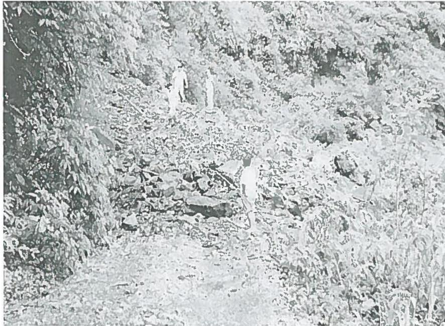
Foto N° 04: **TRAMO 04** Progresiva 5+570 **PUNTO CRITICO** para limpiar por deslizamiento de rocas—Deslizamiento de Taludes.
