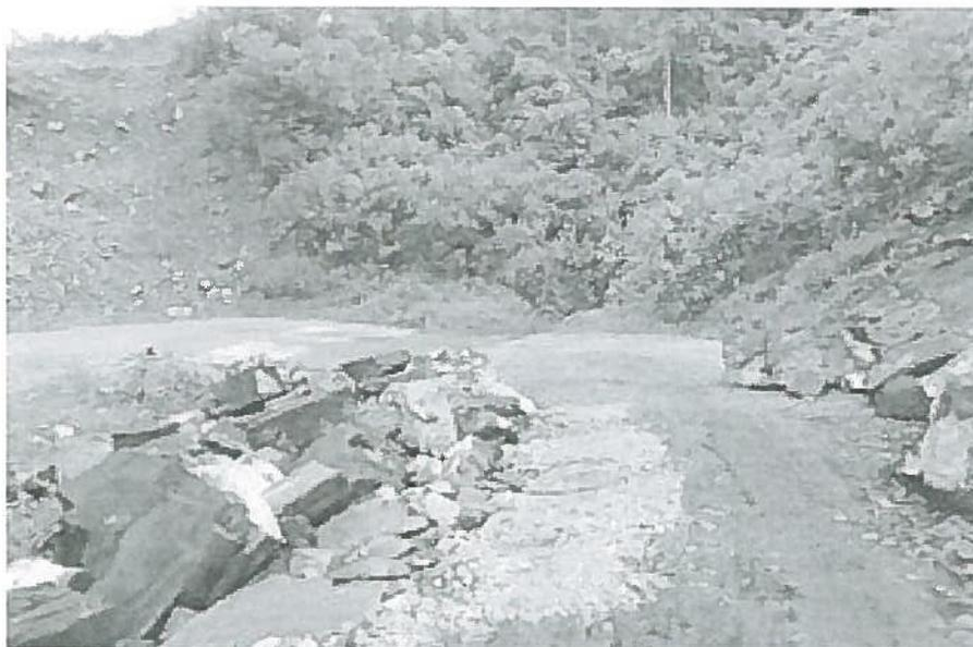
Foto N° 03: Progresiva 98+170 **PUNTO CRITICO** para limpiar por deslizamiento de rocas—Deslizamiento de Taludes.
