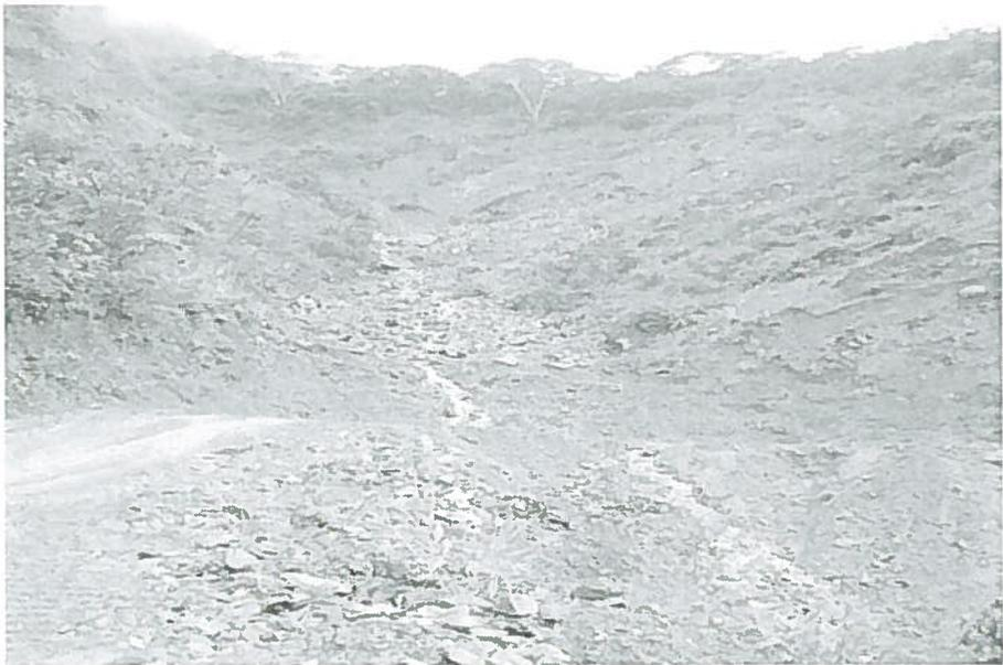
Foto N° 07: **TRAMO 04** Progresiva 17+430 **PUNTO CRITICO** Deslizamiento de Taludes.
