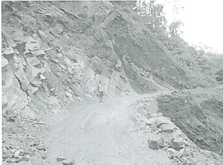
Foto N° 04: TRAMO 05 Progresiva 52+300 PUNTO CRITICO para limpiar por deslizamiento de rocas—Deslizamiento de Taludes.
