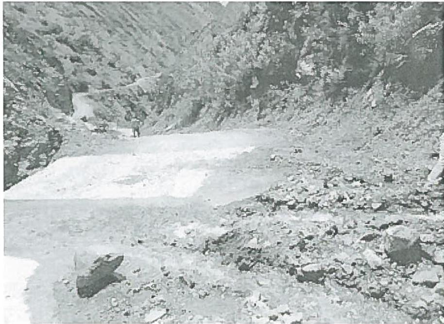
Foto N° 02: Progresiva 86+500 **PUNTO CRITICO** para limpiar por deslizamiento de rocas—Deslizamiento de Taludes.
