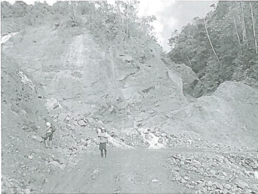
Foto N° 04: TRAMO 05 Progresiva 41+580 PUNTO CRITICO para limpiar por deslizamiento de rocas—Deslizamiento de Taludes.
