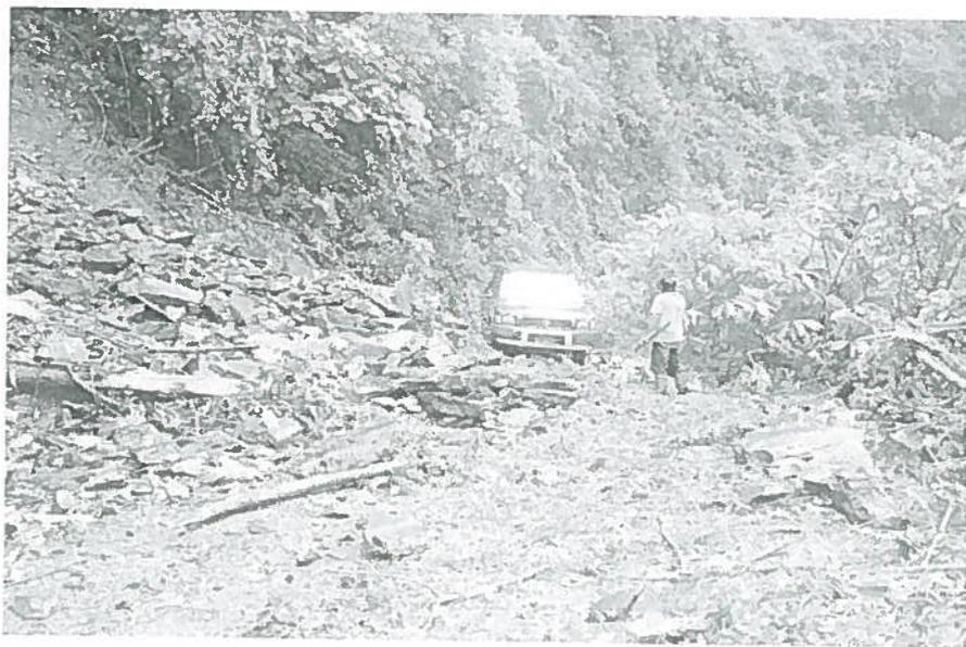
Foto N° 04: TRAMO 04 Progresiva 5+370 PUNTO CRITICO para limpiar por deslizamiento de rocas—Deslizamiento de Taludes.
