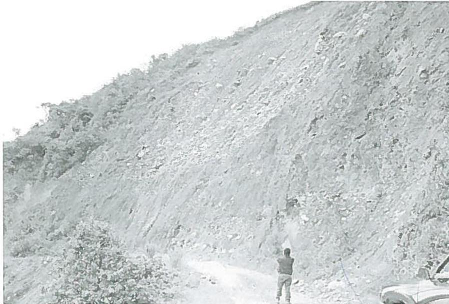
Foto N° 05: **TRAMO 04** Progresiva 5+940 **PUNTO CRITICO** para limpiar por deslizamiento de rocas—Deslizamiento de Taludes.
