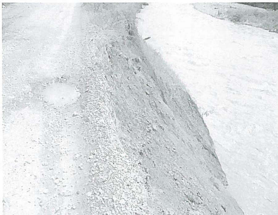
Foto N° 06: TRAMO 04 Progresiva 6+610 PUNTO CRITICO Deslizamiento de Taludes.
