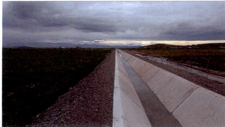
Vista del canal trapezoidal, de reciente construcción.
