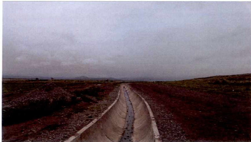
Vista del canal semicircular, de reciente construcción.
