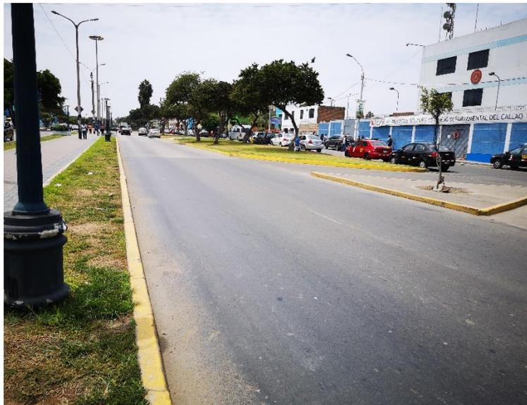
Gráfico N° 49 Se puede apreciar la vía en buen estado, así como el cambio de superficie de rodadura de flexible a rígido.
