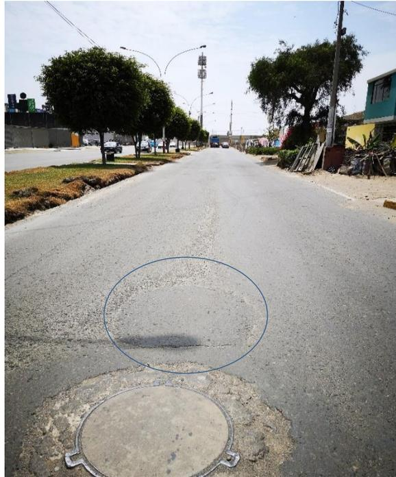
Observación: pulimiento de agregados de severidad alta y parches de severidad baja
