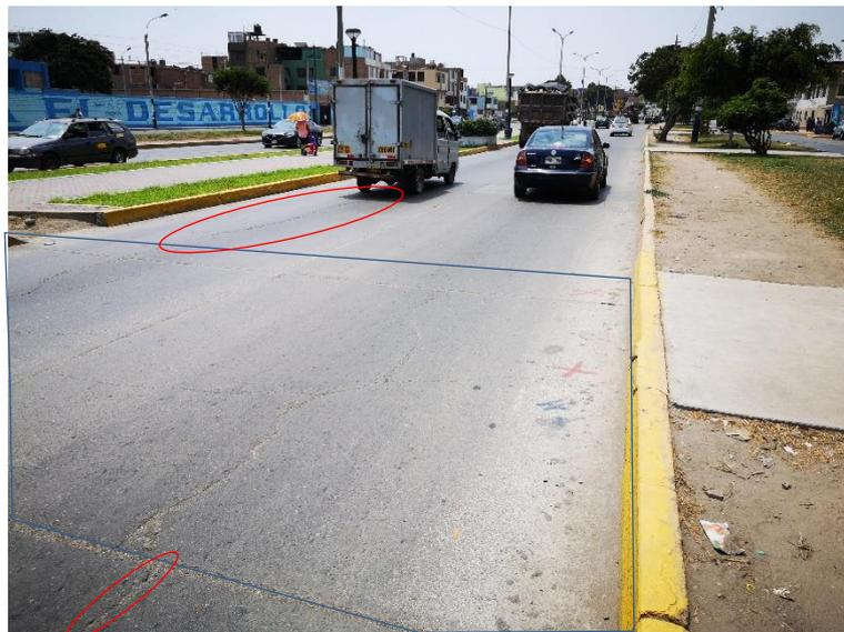
Observación: losa dividida de severidad media y grietas longitudinales de severidad alta.
