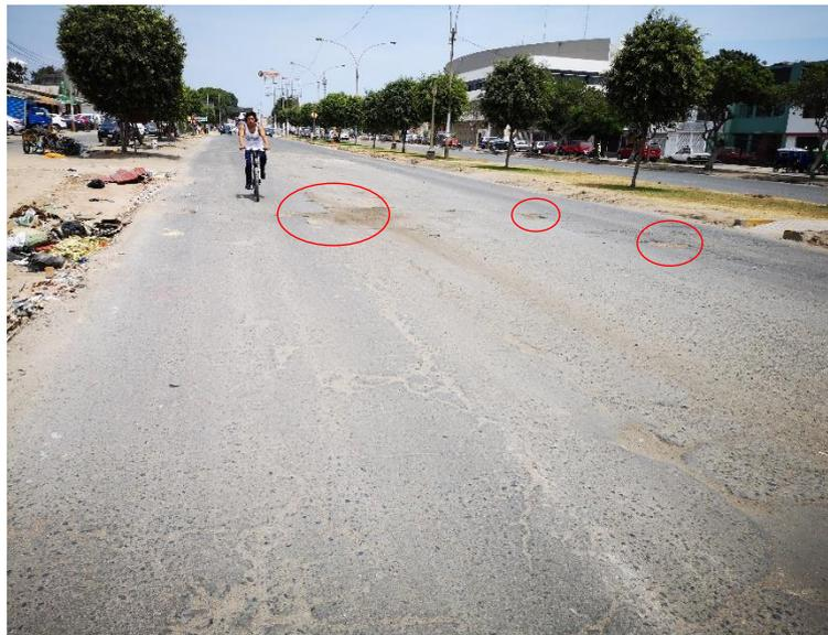
Observación: huecos de severidad alta, pulimiento de agregados de severidad alta y piel de cocodrilo de severidad alta.
