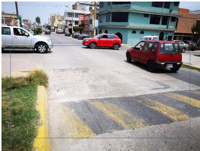
Gráfico N° 43 Se puede apreciar la falla pulimiento de agregados de severidad alta.
