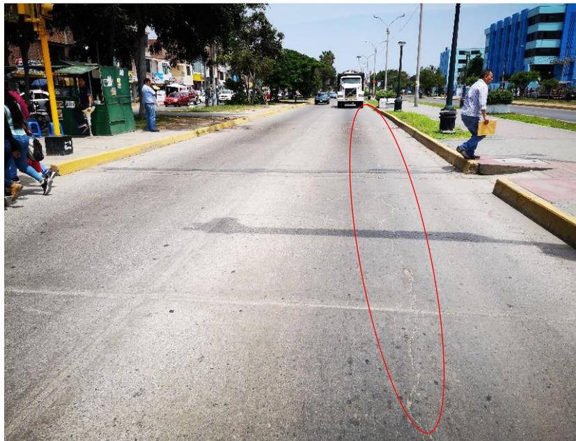
Gráfico N° 53 Se puede apreciar grieta lineal de severidad alta y pulimiento de agregados de severidad media.
