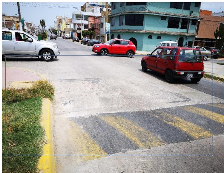
Observación: falla pulimiento de agregados de severidad alta.
