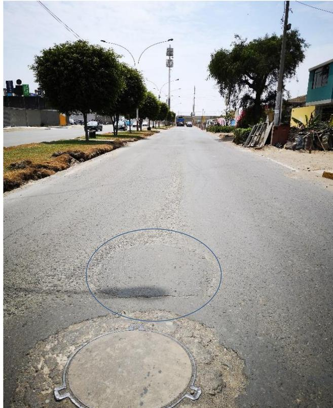
Gráfico N° 56 Se puede apreciar pulimiento de agregados de severidad alta y parches de severidad baja
