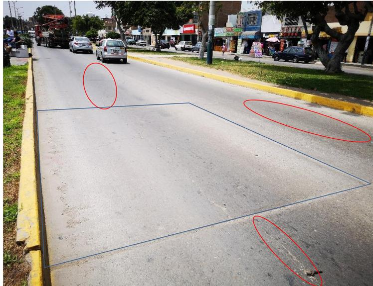
Gráfico N° 52 Se puede apreciar losa dividida de severidad baja, grieta lineal de severidad media y pulimiento de agregados de severidad media.
