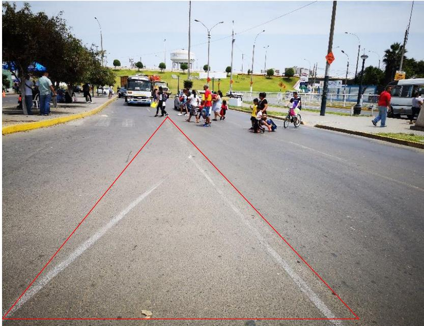
Gráfico N° 48 Se puede apreciar desprendimiento de agregados de severidad baja.
