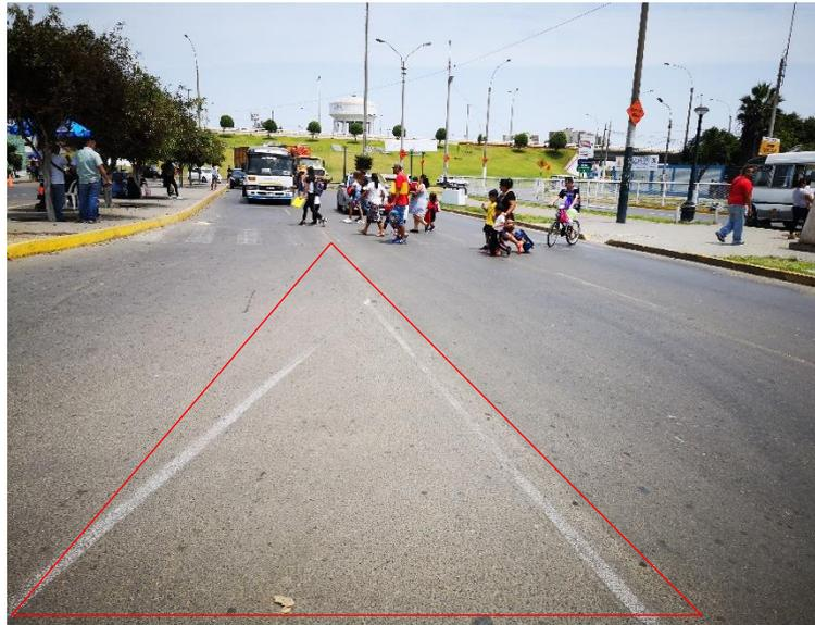
Observación: Desprendimiento de agregados de severidad baja.
