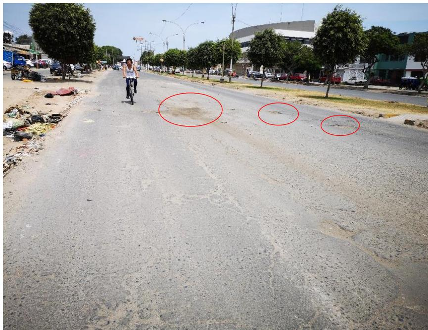
Gráfico N° 59 Se puede apreciar huecos de severidad alta, pulimiento de agregados de severidad alta y piel de cocodrilo de severidad alta.
