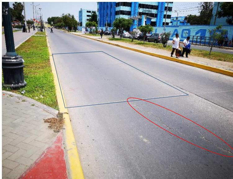
Observación: fisura longitudinal de severidad alta, losa dividida de severidad baja y pulimiento de agregados de severidad baja.
