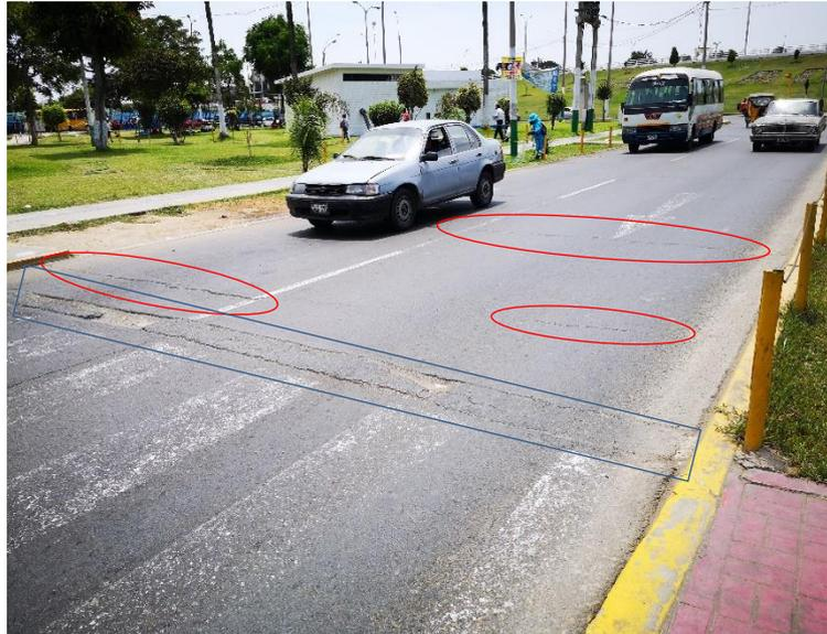
Observación: parche en pésimo estado de severidad alta, grietas longitudinales de severidad alta y pulimiento de agregados de severidad media.
