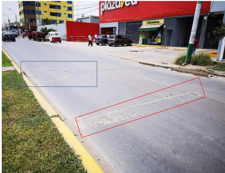
Gráfico N° 42 Se puede apreciar la falla parcheo de severidad alta y falla de esquina de severidad alta.
