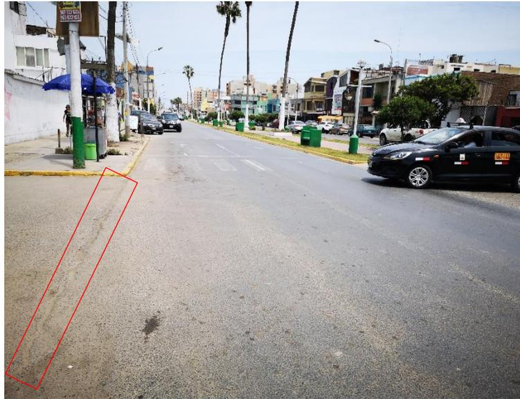
**Observación:** fisuras longitudinales de severidad alta y pulimiento de agregados de severidad media.
