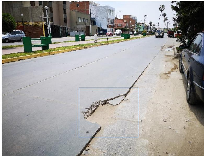
Gráfico N° 41 Se puede apreciar la falla grieta de borde de severidad alta, así mismo se puede apreciar desnivel carril berma.
