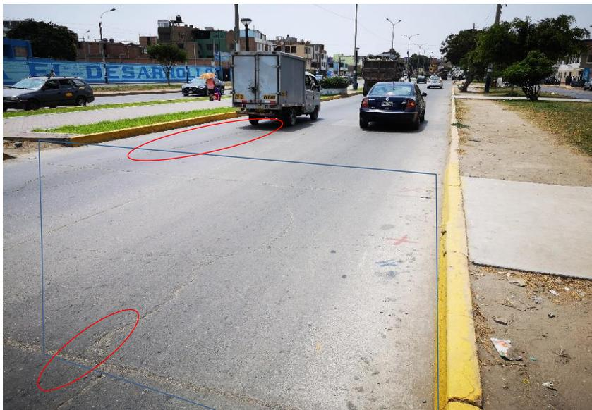
Gráfico N° 55 Se puede apreciar losa dividida de severidad media y grietas longitudinales de severidad alta.
