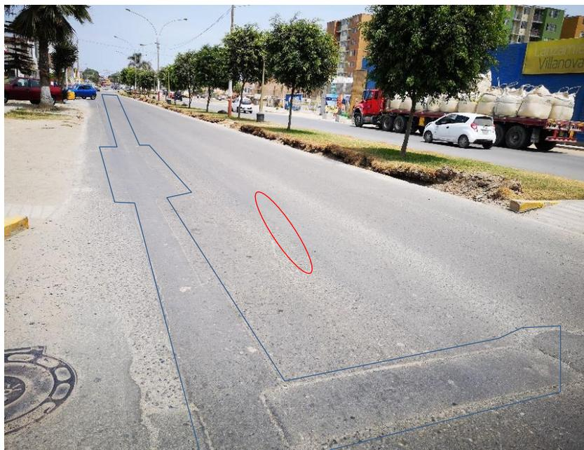
Gráfico N° 57 Se puede apreciar fisura longitudinal de severidad baja, pulimiento de agregados de severidad media y parcheo de severidad media
