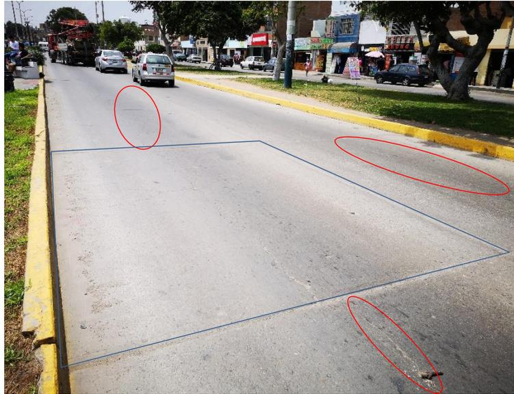
Observación: losa dividida de severidad baja, grieta lineal de severidad media y pulimiento de agregados de severidad media.
