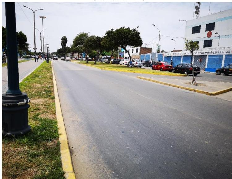
Observación: la vía en buen estado, así como el cambio de superficie de rodadura de flexible a rígido.
