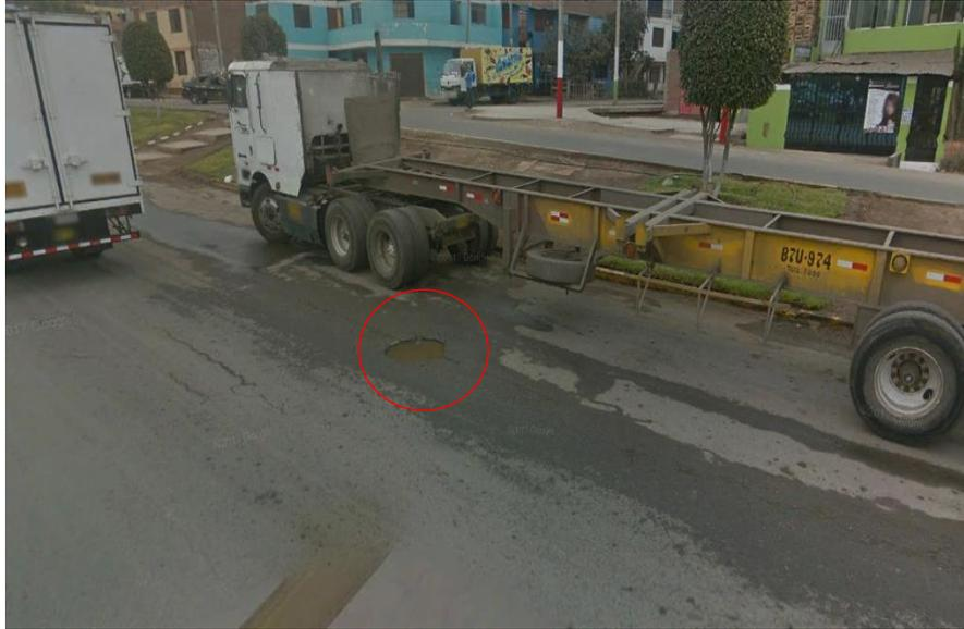
Gráfico N° 60 Se puede apreciar huecos de severidad media en la vía.
