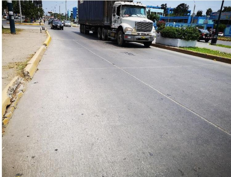
Observación: pulimiento de agregados de severidad baja.
