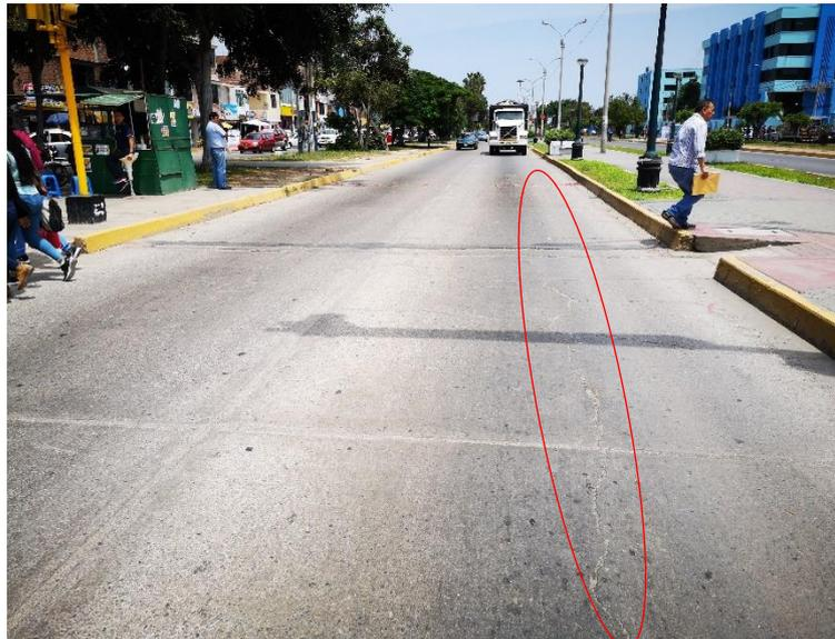
Observación: grieta lineal de severidad alta y pulimiento de agregados de severidad media.
