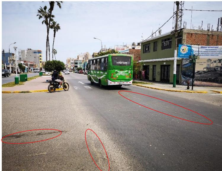
Observación: fisuras longitudinales de severidad media y pulimiento de agregados de severidad media
