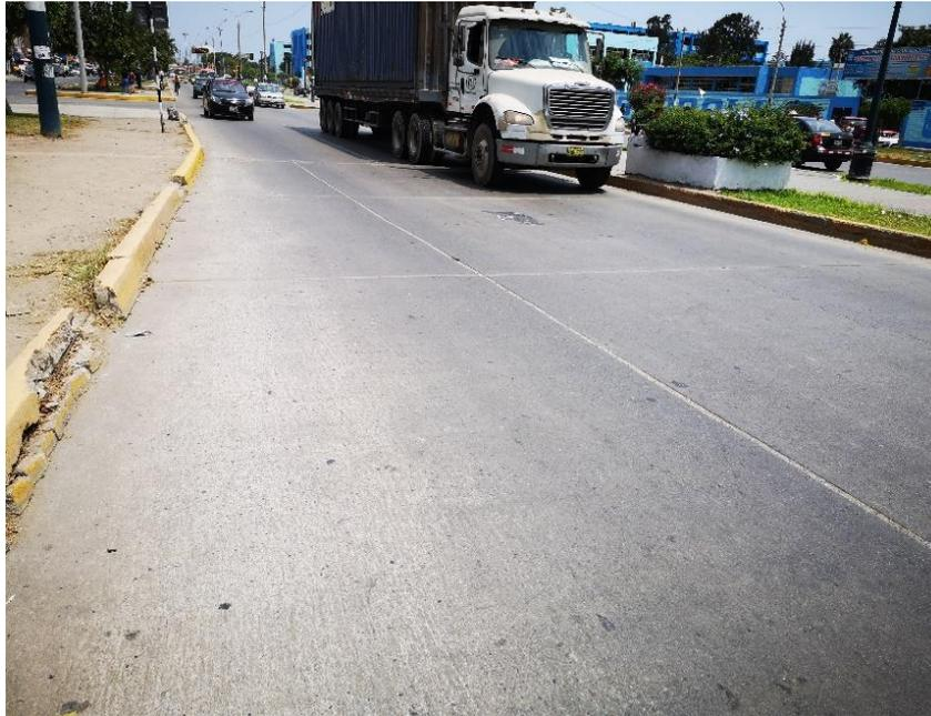
Gráfico N° 54 Se puede apreciar pulimiento de agregados de severidad baja.
