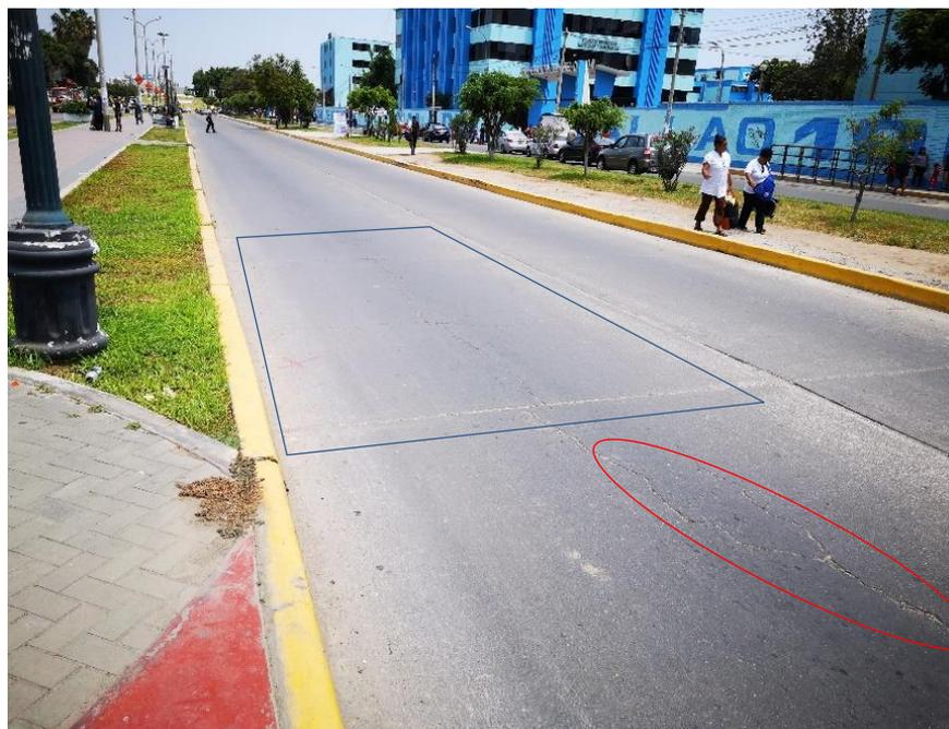
Gráfico N° 51 Se puede apreciar fisura longitudinal de severidad alta, losa dividida de severidad baja y pulimiento de agregados de severidad baja.
