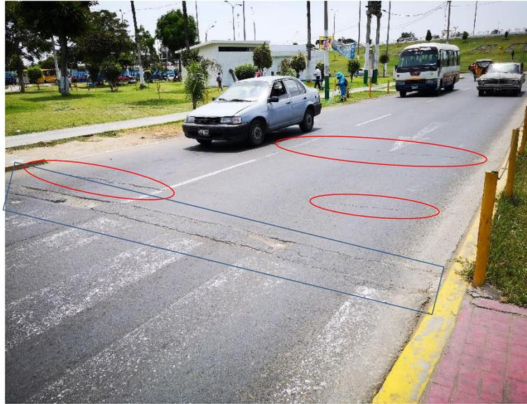
Gráfico N° 46 Se puede apreciar parche en pésimo estado de severidad alta, grietas longitudinales de severidad alta y pulimiento de agregados de severidad media.
