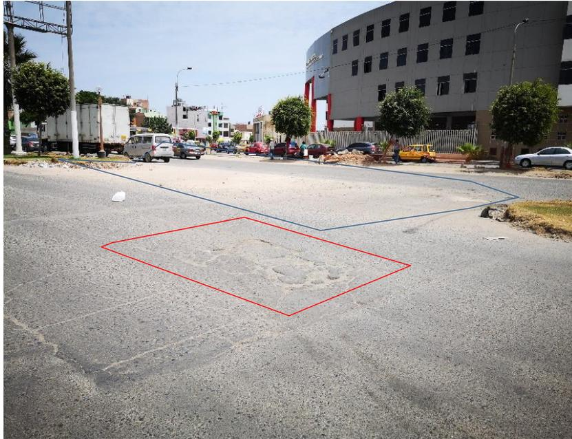
Gráfico N° 58 Se puede apreciar huecos de severidad alta, pulimiento de agregados de severidad alta y piel de cocodrilo de severidad alta
