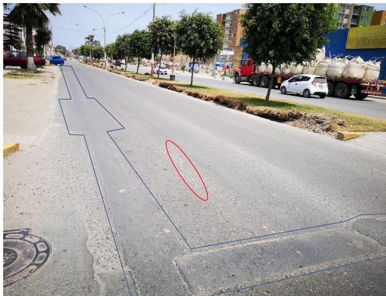
Observación: fisura longitudinal de severidad baja, pulimiento de agregados de severidad media y parcheo de severidad media
