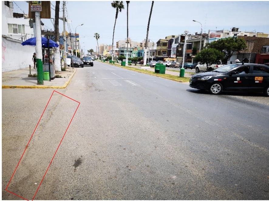
Gráfico N° 44 Se puede apreciar fisuras longitudinales de severidad alta y pulimiento de agregados de severidad media.
