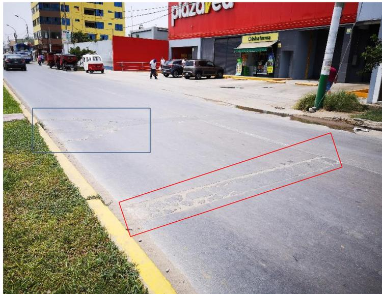
Observación: falla parcheo de severidad alta y falla de esquina de severidad alta.
