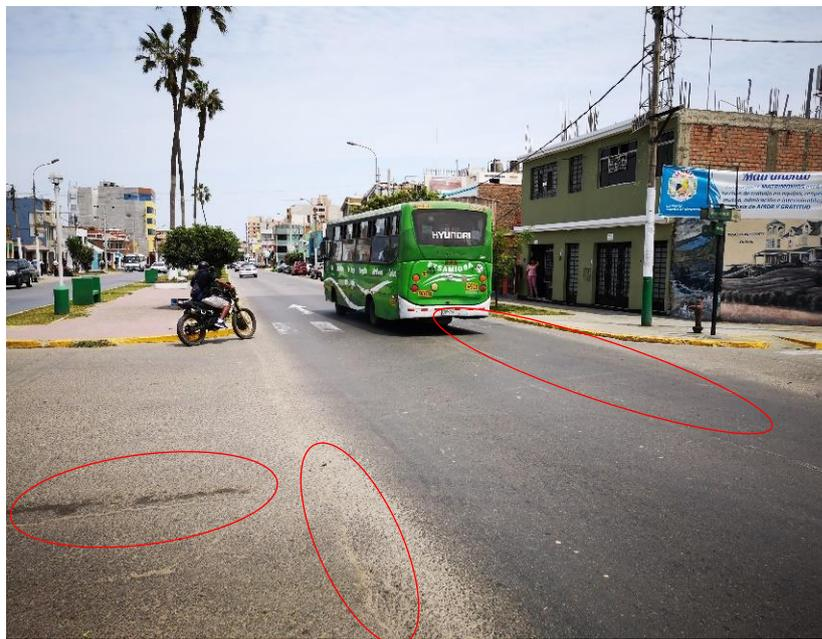
Gráfico N° 47 Se puede apreciar fisuras longitudinales de severidad media y pulimiento de agregados de severidad media
