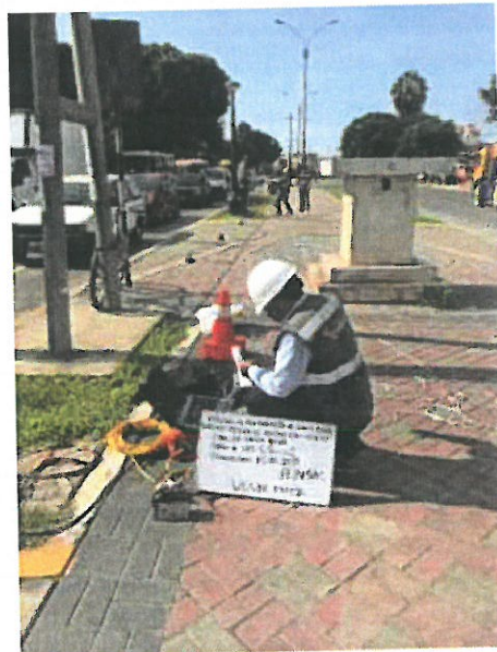
Toma de datos con el equipo Geode Seismic
