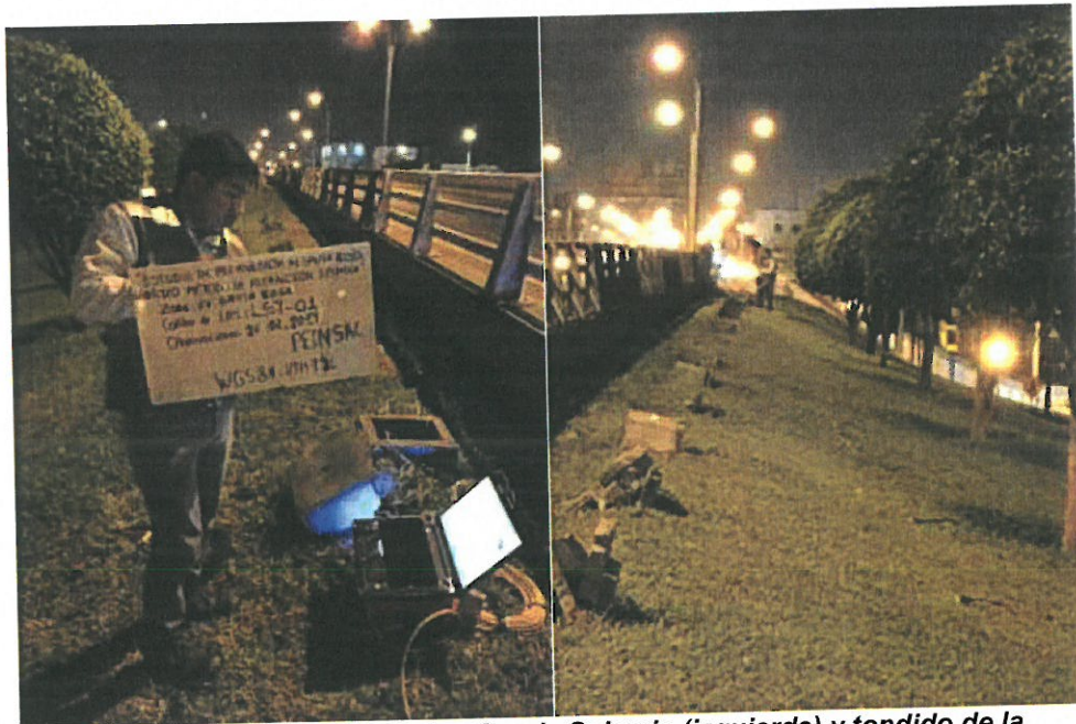
Toma de datos con el equipo Geode Seismic (izquierda) y tendido de la línea sísmica (derecha)
