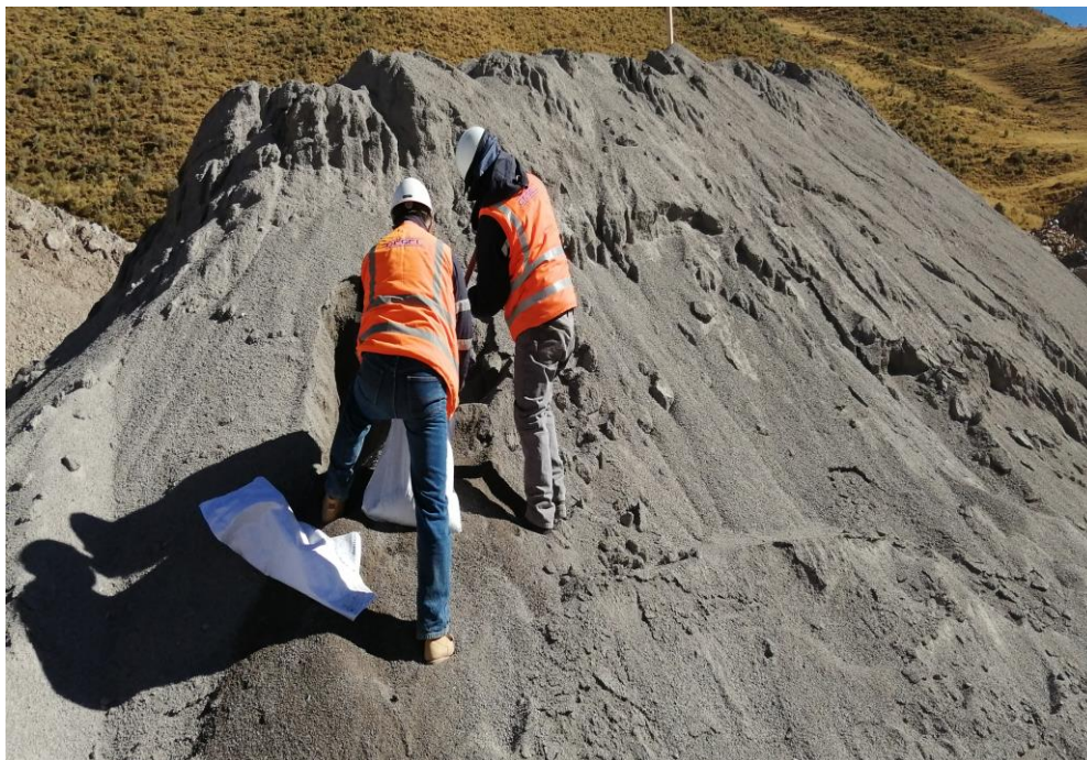
FOTO N°: 06 Muestreo de Agregados Para Concreto de la Planta Chancadora Km. 29+700 L/D.
