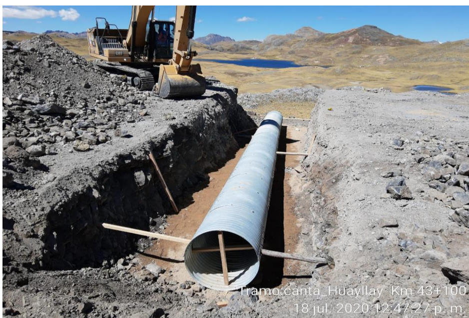
FOTO N° 02 Colocacion del Tubo T.M.C. DE 36"Ø Km.43+100 P/C.
