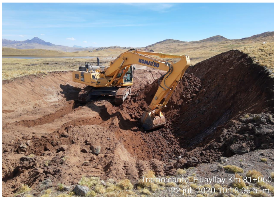
FOTO N°: 04 Excavacion de Corte Cerrado del Km.80+830 al Km.81+130 P/C.
