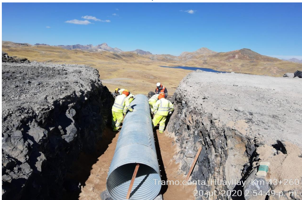
FOTO N° : 01 Colocacion de Tubo Alc. T.M.C. 36"Ø Km.43+260 P/C
