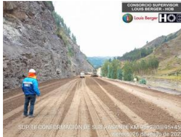
SUP TII CONFORMACIÓN DE SUB RASANTE KM 94+000@94+200 Viernes, 26 de mayo de 2023
