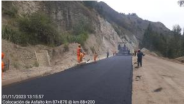
01/11/2023 13:15:57 Colocación de Asfalto km 87+870 @ km 88+200
