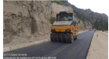
01/11/2023 13:18:52 Colocación de Asfalto km 87+870 @ km 88+200
