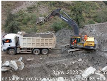
3 nov. 2023 7:49:06 a. m. de talud y excavación y en rogado km 89 +040
