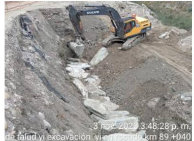
3 nov. 2023 3:48:28 p. m. de talud y excavación y en rogado km 89 +040
