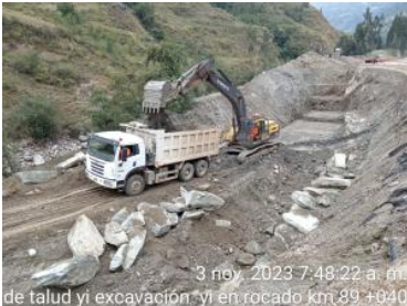
3 nov. 2023 7:48:22 a. m. de talud y excavación y en rogado km 89 +040
