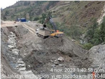
4 nov. 2023 1:37:57 p.m. de talud y excavación y en rogado km 89+040
