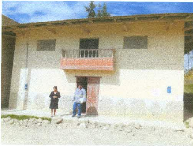
VISTA FRONTAL DEL PREDIO AFECTADO – NUEVA AFECTACION
