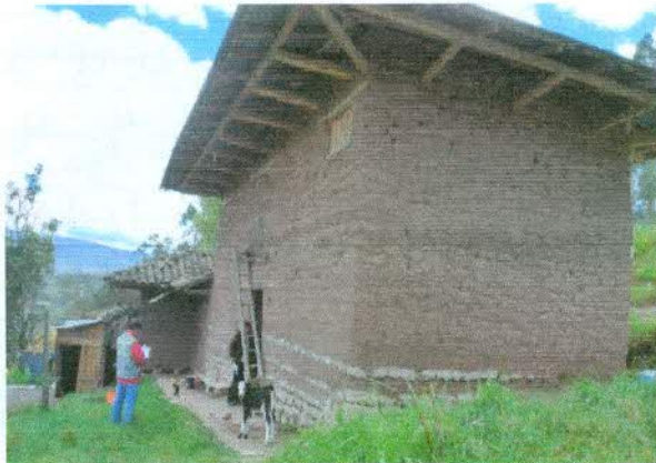
VISTA POSTERIOR -FONDO, DEL PREDIO AFECTADO - NUEVA AFECTACION
