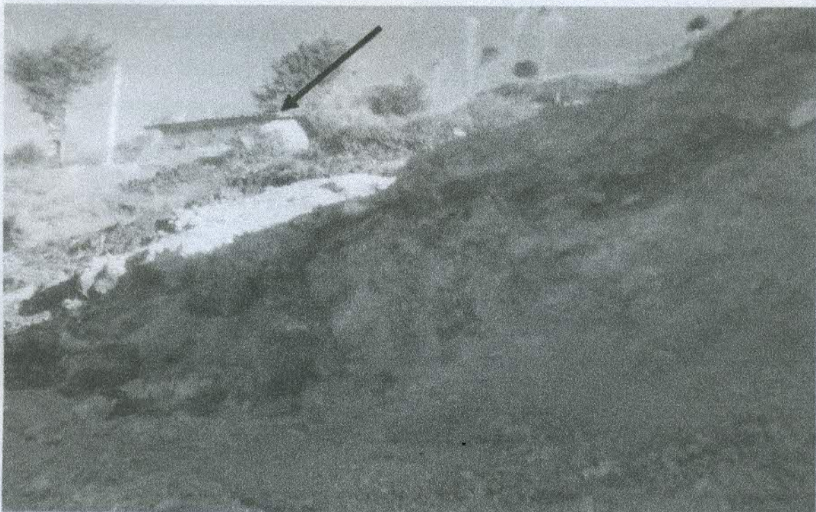
VIVIENDA QUE PUEDE SER AFECTADA DEBIDO AL DESLIZAMIENTO DE TIERRA
