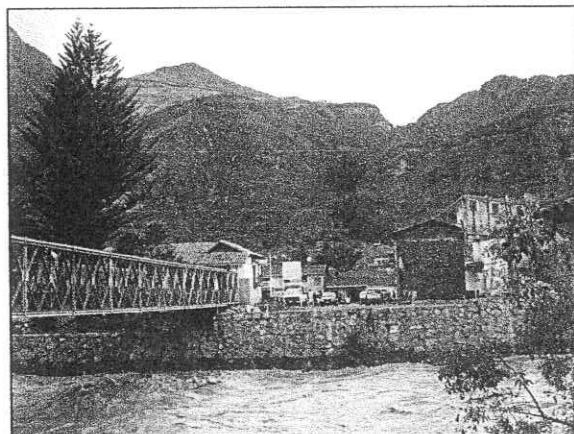
Foto N° 4.- Vista de la base del puente en la margen derecha del río Vilcanota
