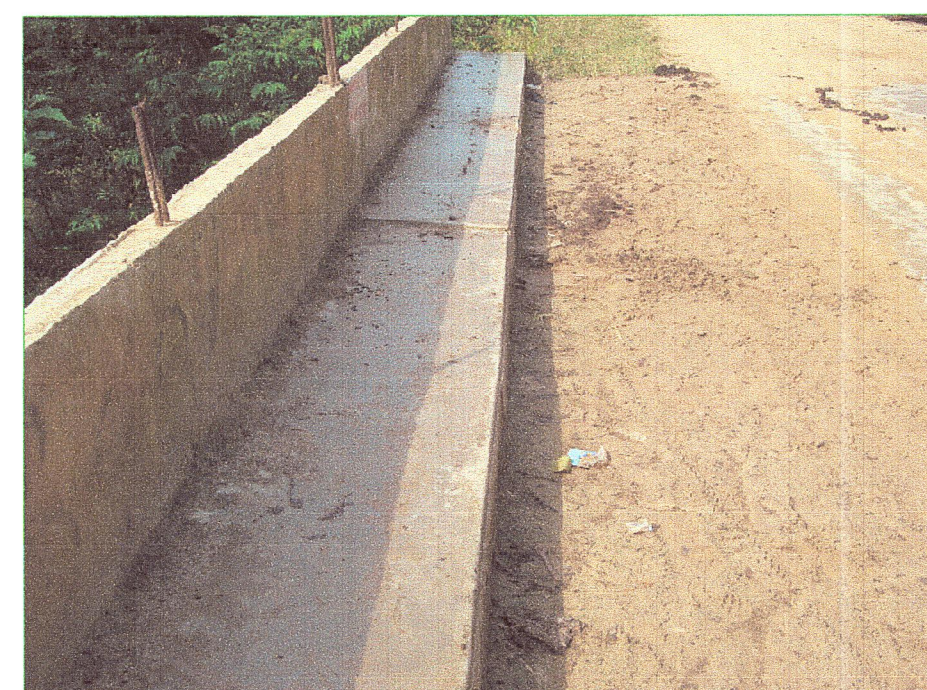
05 Vista lateral de vereda y parapeto
