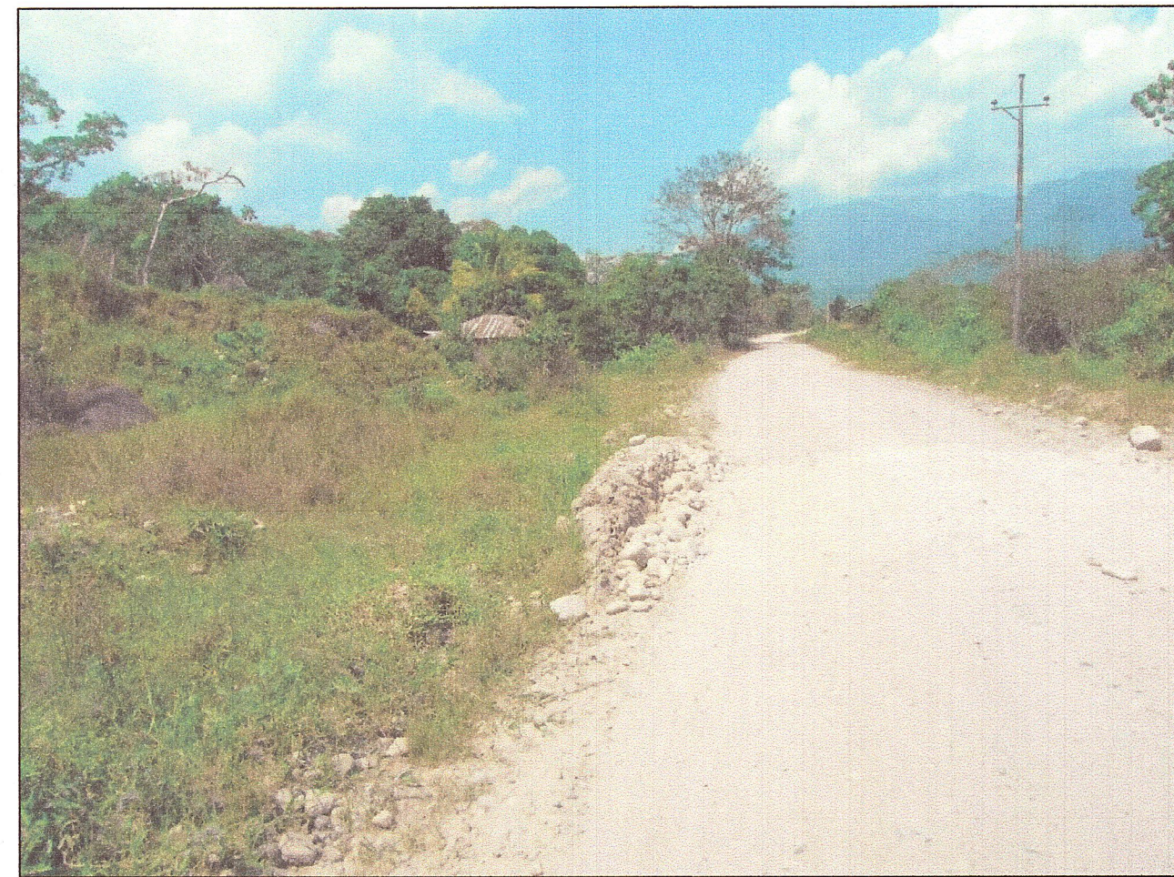
VISTA PANORAMICA DE LA CARRETERA
