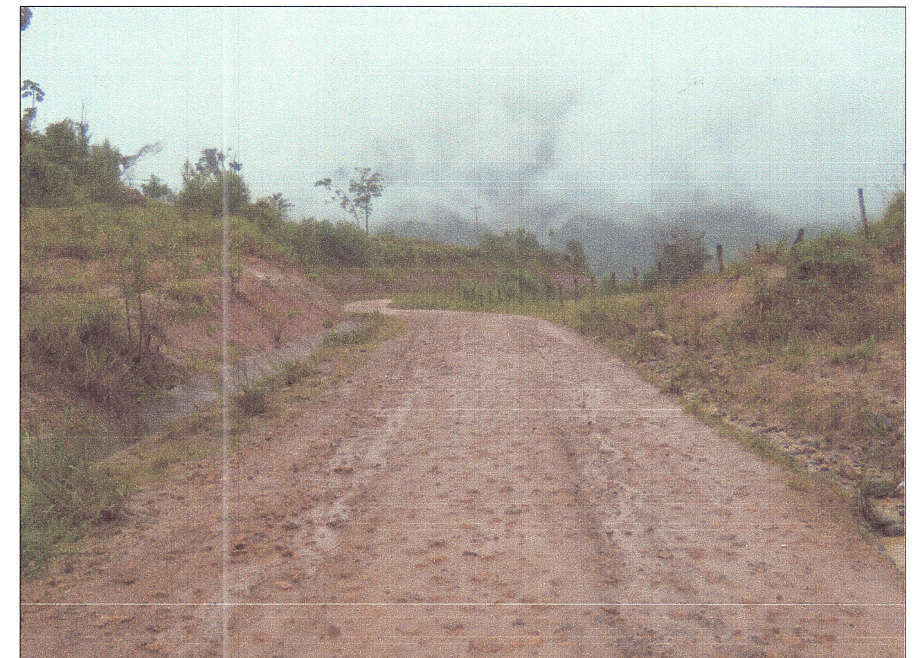
Carretera existente ,con mantenimiento a nivel de afirmado de 3.50m. de ancho
