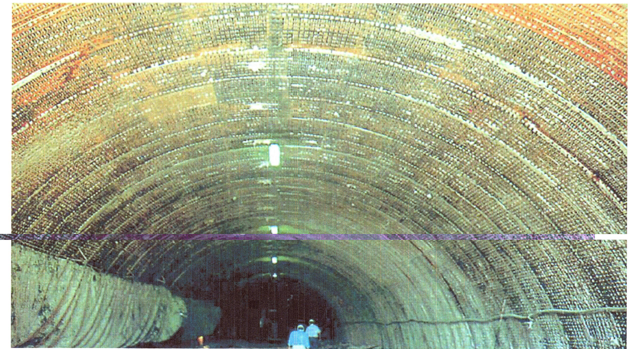
ACABADO TUNEL CON PLANCHA DE ACERO TIPO BERNOLD
