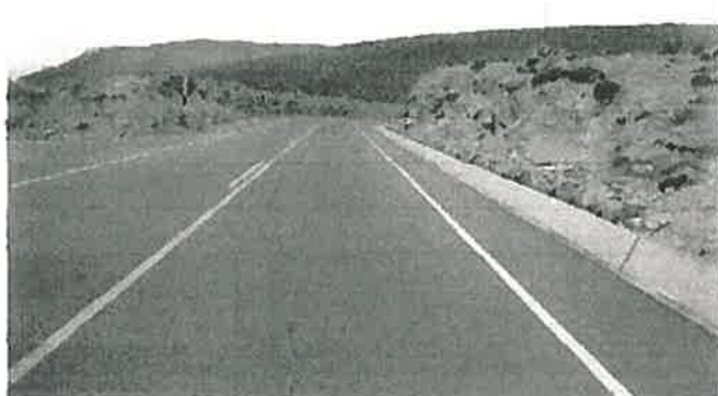
Foto Nº 3 Inicio del Tramo Humajalso – Desaguadero Se puede observar que este tramo se encuentra en buenas condiciones
