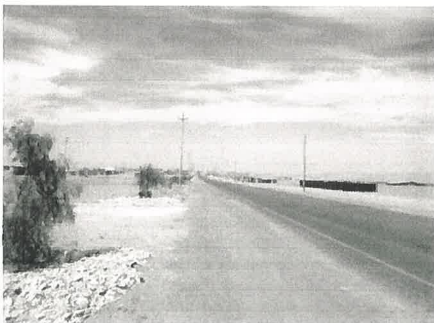
Foto N° 6 Presencia de asentamientos humanos en ambos márgenes de la Carretera.
