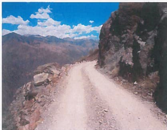
Insuficiencia de ancho de la vía para el cruce de vehículos. normal.
