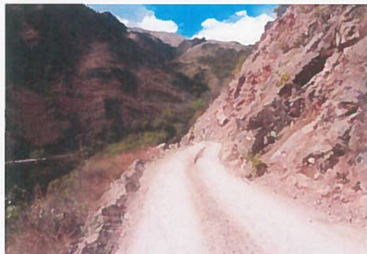
Nótese, bajada al distrito de Tambobamba con mínimo ancho de la vía, la cual genera dificultades de paso de vehículos laterales.
