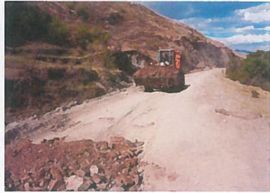
Personal del Provias Departamental realizando trabajos de Mantenimiento preventivo en los sectores criticosde la vía.
