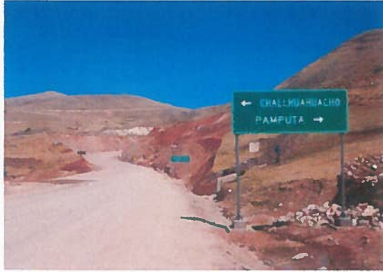
Nótese, el afirmado existente en la zona del cruce de Queuira.
