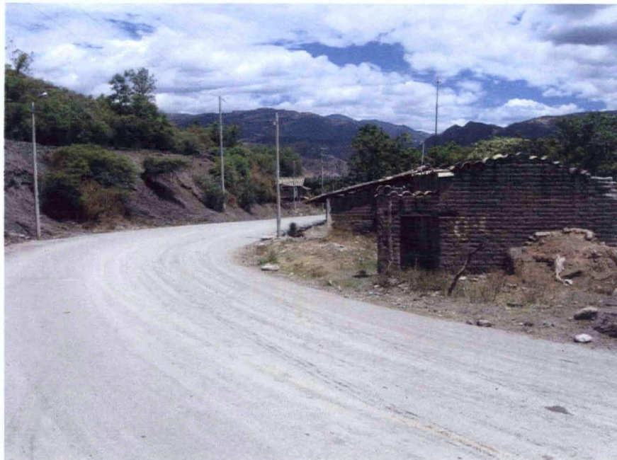
VISTA DE LA VÍA ANTES DEL PUENTE
