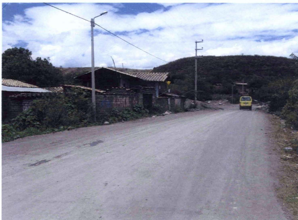
VISTA DE LA VÍA DESPUÉS DEL PUENTE
