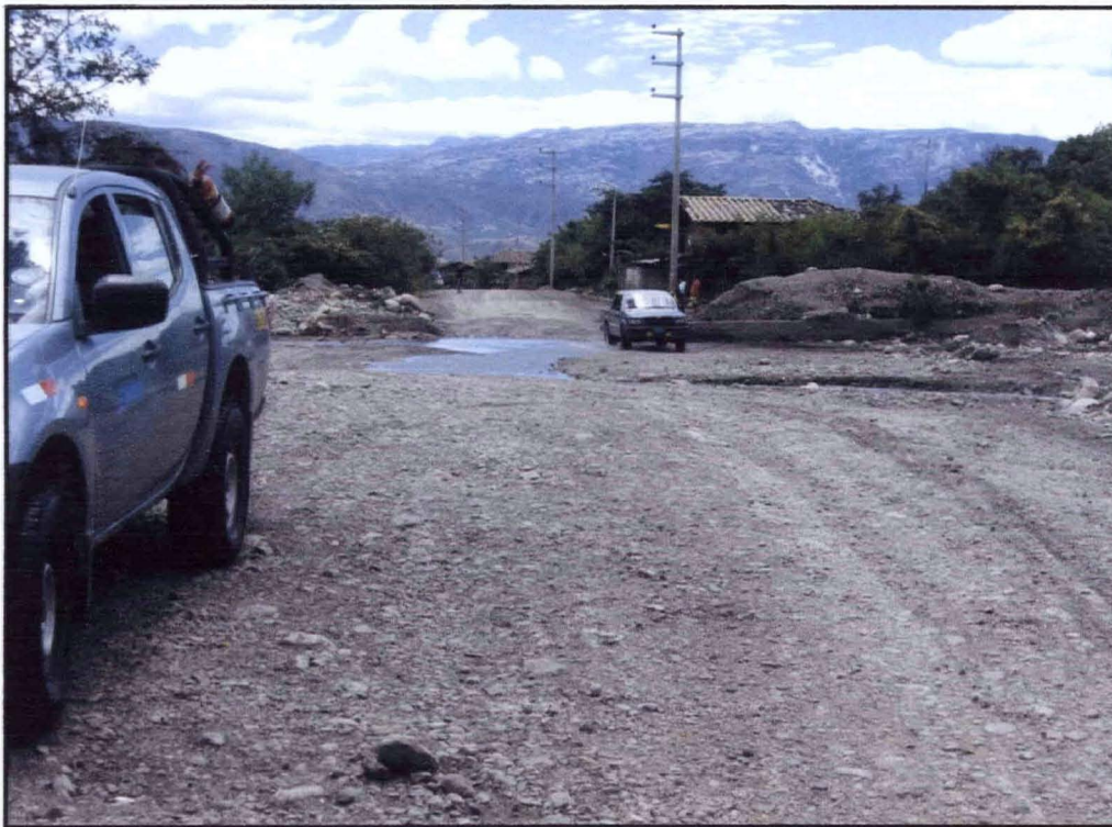
LUGAR DE EMPLAZAMIENTO DEL PUENTE EN RIO MALCAS
