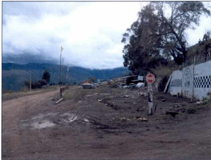
Fig.18: Se pudo observar una señal reglamentaria R-1 (PARE) de material plástico adherida a un poste de metal ubicada en la progresiva 4+120, en sentido Noreste – Suroeste.
