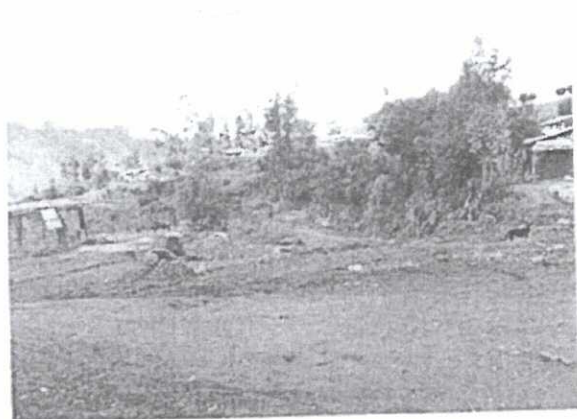
Vista del Km 6+000
