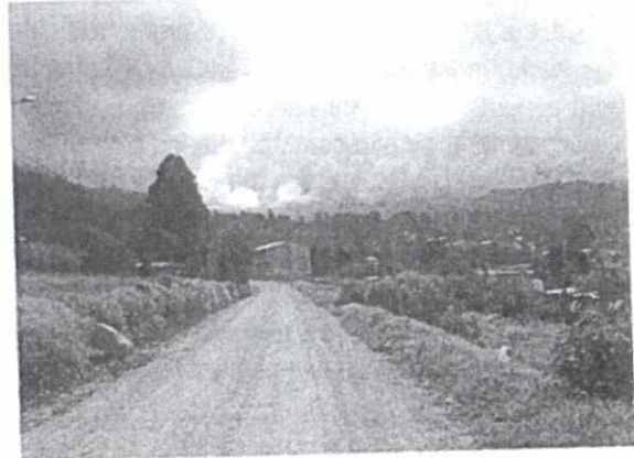
Vista del Km 8+00 Carretera Afirmada
