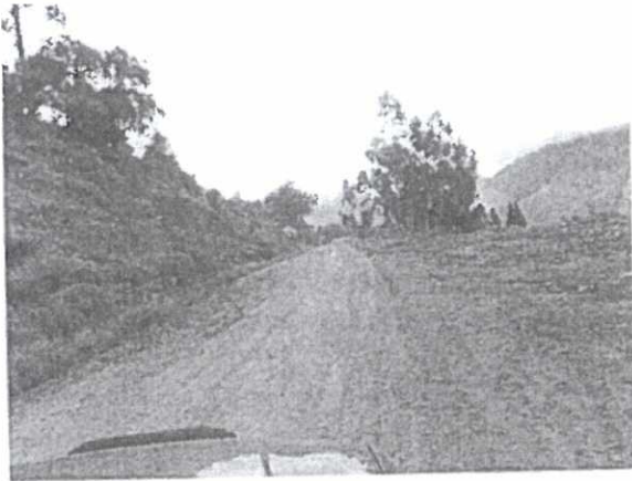
Vista del Km 4+000
