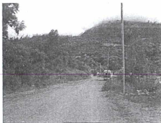
Vista del Km 2+000 Carretera Afirmada
