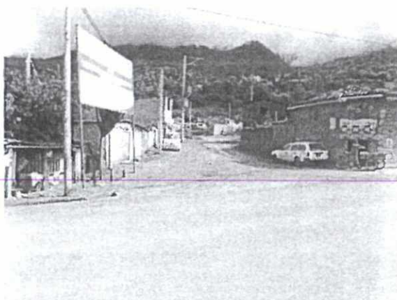
Vista del Km 0+000 Inicio del Proyecto
