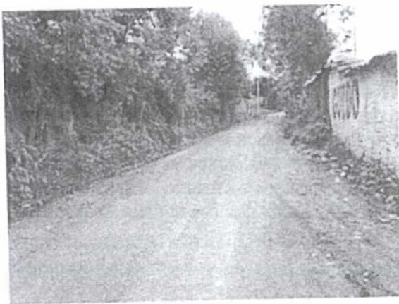
Vista del Km 7+000 Carretera Afirmada
