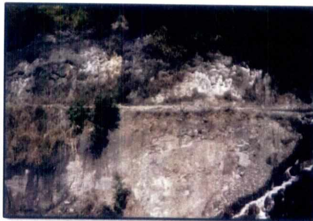
Fotografía 3: Quebrada Huancarccasa. Entrada al túnel 01
