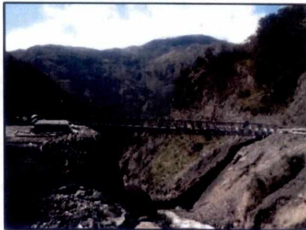
Fotografía 4: Vista P.K. 11+300. Puente Quellomayo
