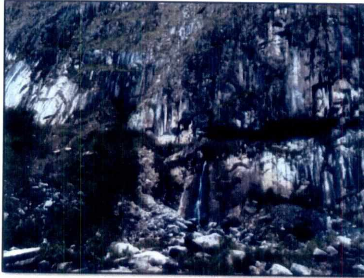
Fotografía 7: Salida de la galería de la Central Hidroeléctrica Machu Picchu
