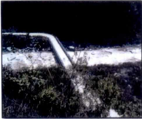
Fotografía 9: Cruce puente Vilcanota
