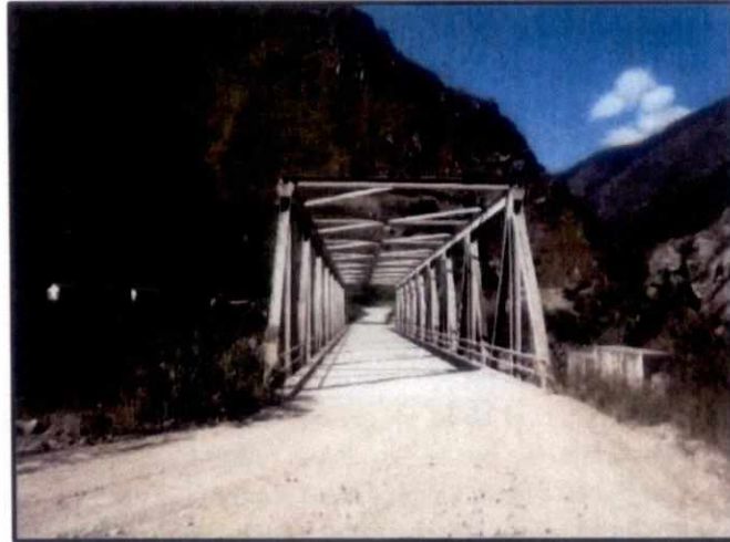
Fotografía 6: Puente de Carrilluchayoc
