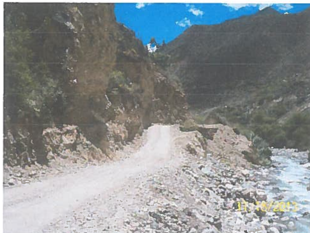
Erosión Fluvial Plataforma Rehabilitada
