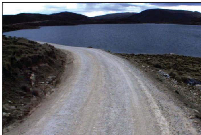
Imagen 2: Tramo I (Km 15+537)
