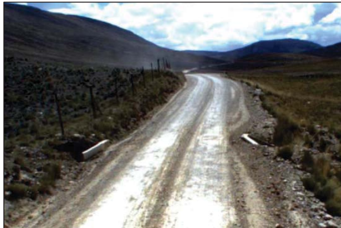
Imagen 1: Tramo I (km 4+715)
