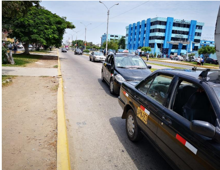
Se puede apreciar pulimiento de agregados de severidad media.
