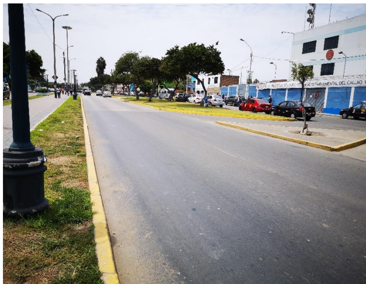
Se puede apreciar la vía en buen estado, así como el cambio de superficie de rodadura de flexible a rígido.
